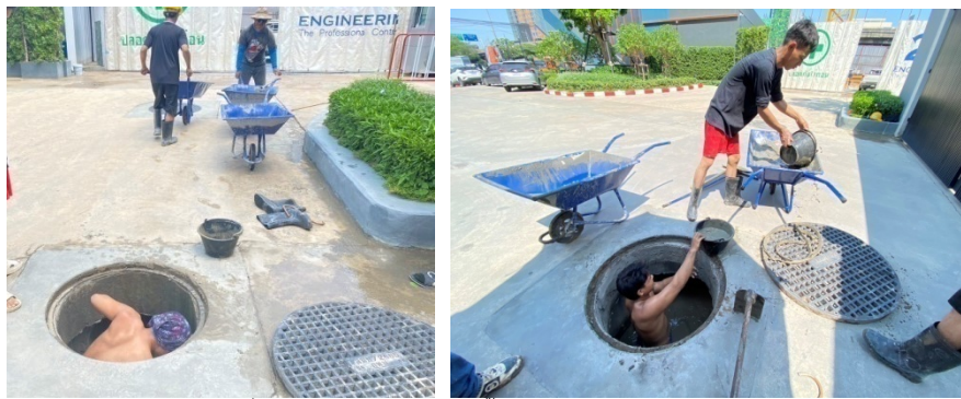
ภาพที่ 5-21 ขุดลอกท่อระบายน้ำหลังจากการเสาะเข็มแล้วเสร็จ
