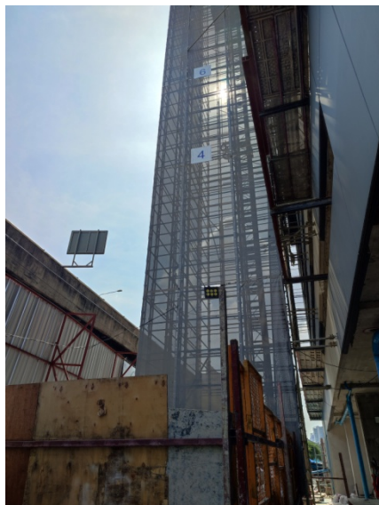
ภาพที่ 5-30 ติดตั้งลิฟต์ขนส่งของ เท้ากับความสูงการก่อสร้างอาคาร และภาพที่ 5-31 ห้องนั่งทางเดินและถังดับเพลิงเคมีประจำโครงการ
