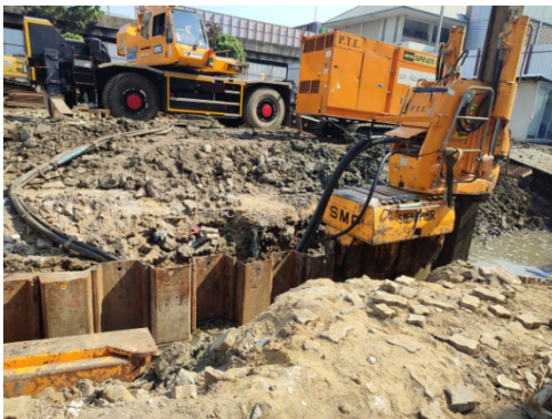
ภาพที่ 5-12 ทำเสาเข็มแบบเจาะ ชนิดเป็ยก และกด Sheet Pile
