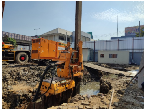
ภาพที่ 5-12 ทำเสาเข็มแบบเจาะ ชนิดเป็ยก และกด Sheet Pile
