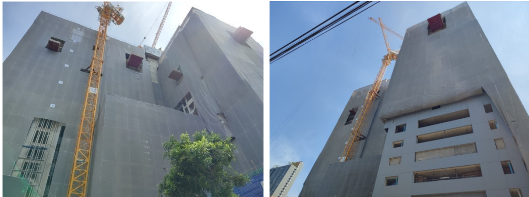
ภาพที่ 5-28 ปิดคลุมอาคารด้วยผ้าใบกันไฟลามอย่างมิดชิดทุกชั้นความสูงอาคาร
